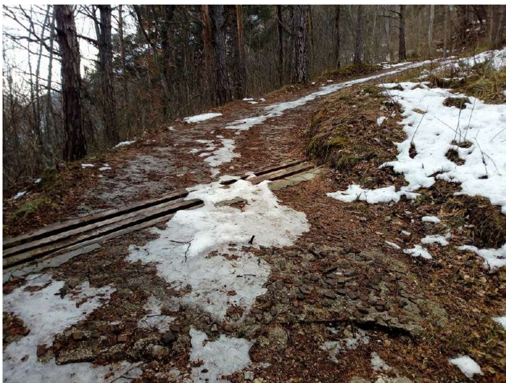
Fig. 10: inizio del cemento esistente: in corrispondenza delle due canalette a destra sarà livellato il basso spuntone di roccia che ostacola i mezzi in interno curva.
