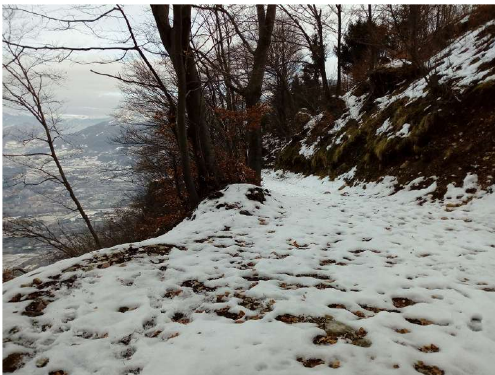
Fig. 23: Piazzola/slargo di svolta dove termina l'intervento di posa del nuovo guardrail; pochi metri più avanti la strada diventa di tipo A in corrispondenza della stanga forestale.
