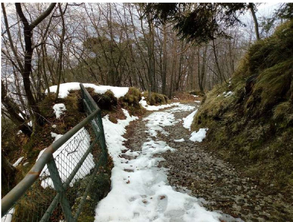
Fig. 18: Tratto pavimentato con semivurva che necessita di un leggero allargamento per facilitare il transito dei mezzi (demolizione in roccia).
