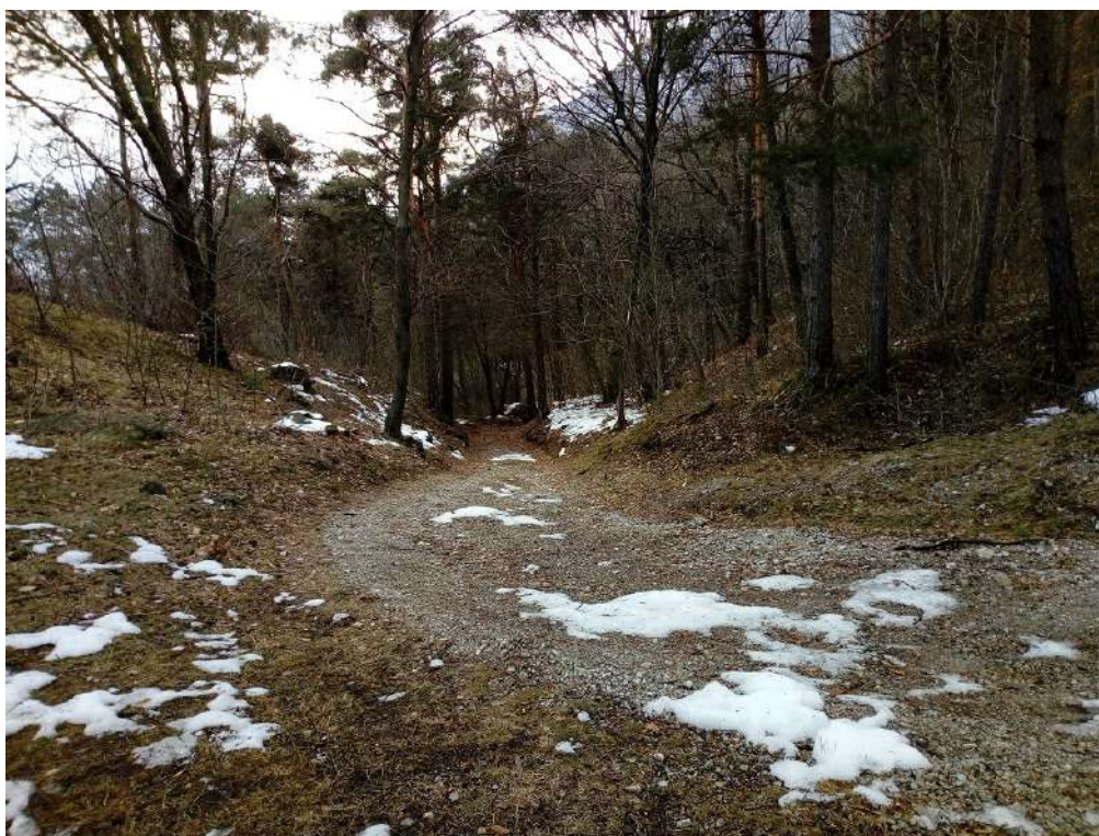
Fig. 7: canale in terra che sarà migliorato con una canaletta in ferro e punto in cui terminerà la nuova soletta in calcestruzzo. Il pino a bordo strada sarà uno dei pochi a dover essere tagliato.
