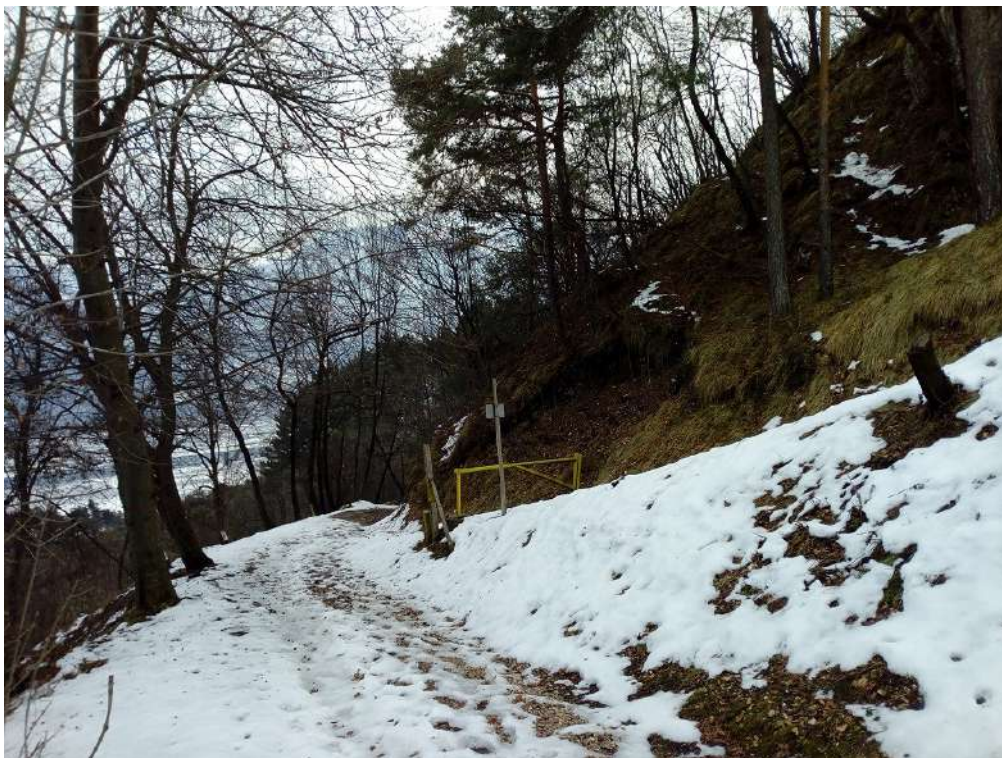
Fig. 17: Tratto sterrato in corrispondenza delle proprietà private coltivate (e inizio area ZSC) dove si aggiungeranno alcune canalette in ferro e si ricaricherà la carreggiata con la finitura superficiale.
