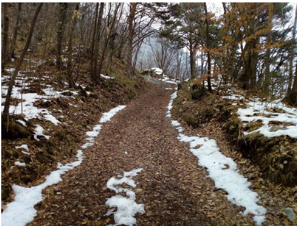
Fig. 12: Tratto in leggera trincea già pavimentato dove si prevede solo un piccolo allargamento della carreggiata dalla parte di monte (in roccia) in corrispondenza della curva.
