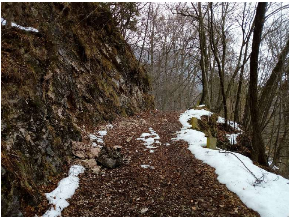
Fig. 14: Tratto terminale del selciato, la parete di roccia a monte necessita di un disgaggio per eliminare i massi instabili. Si notano a terra quelli caduti nell'autunno 2021.
