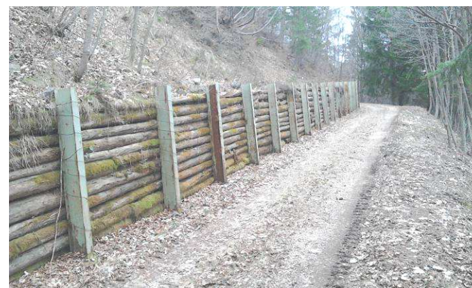
Strada trattorabile Stelar nella frazione di Povo con vecchia opera di sostegno in putrelle e legname
