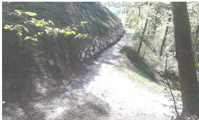
Strada trattorabile Val Granda nella frazione di Povo recentemente ristrutturata con opere di sostegno in massi
