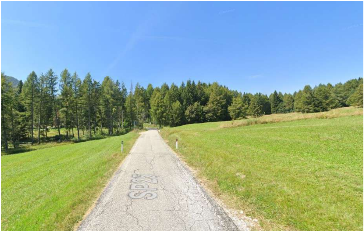
Fig. 5: prosegue il tratto centrale del percorso.
