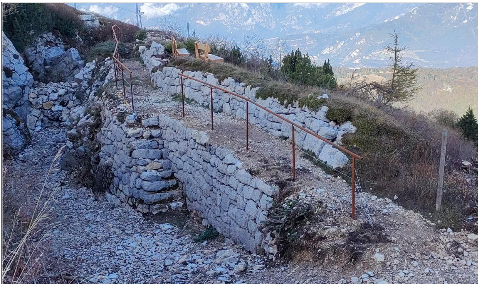
Località Fortino: recupero dei percorsi storici tra Vason e Cima Palon
